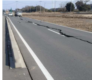
地割れした道路
